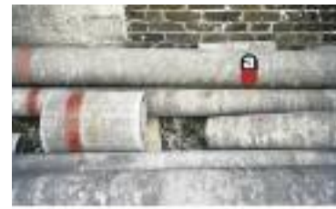
Dans les canalisations en amiante-ciment
