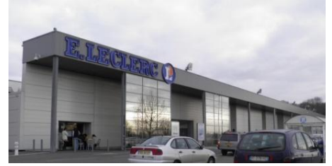
Centre commercial Leclerc à Trie Château Photo : CCITO, Fév. 2012
