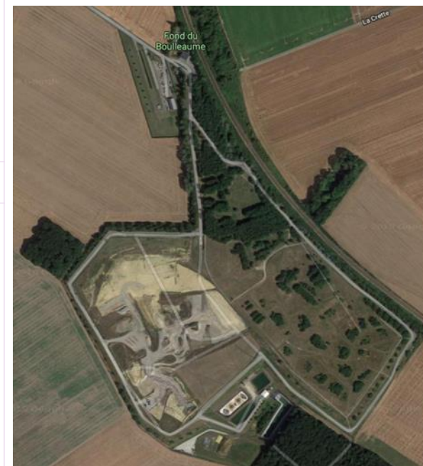
Photo aérienne de l'ISDND de Liancourt-Saint-Pierre
