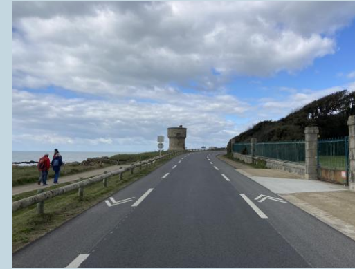
Chaussée à Voie Centrale Banalisée
