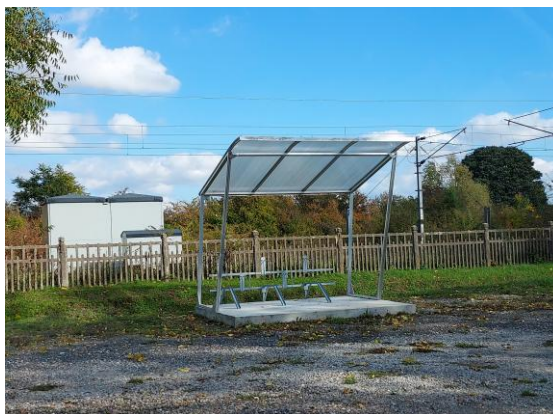
Gare de Liancourt St-Pierre
