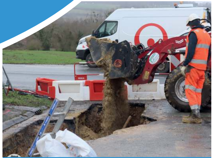
Travaux de renouvellement des canalisations d'eau potable à Courcelles-lès-Gisors - février 2026
