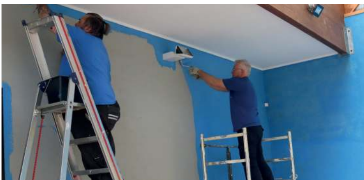
Rénovation du hall du gymnase Guy de Maupassant à Chaumont-en-Vexin - avril 2026
