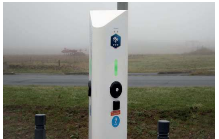
Installation de bornes électriques de recharge à Chaumont-en-Vexin - janvier 2026
